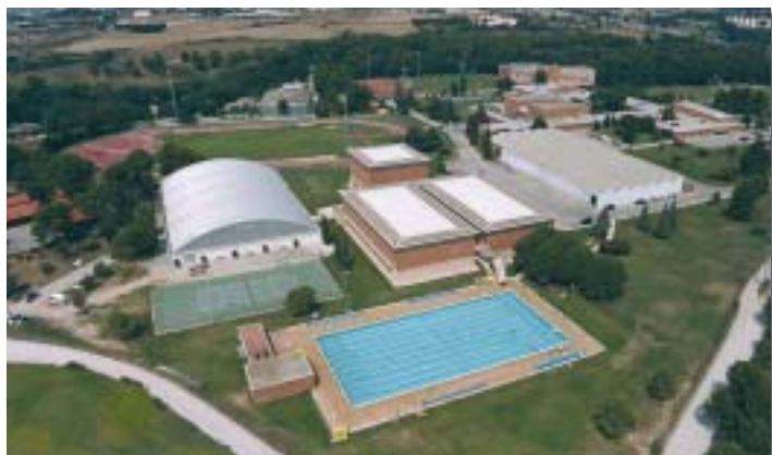
Instal·lacions del Centre d'Alt Rendiment de Sant Cugat
